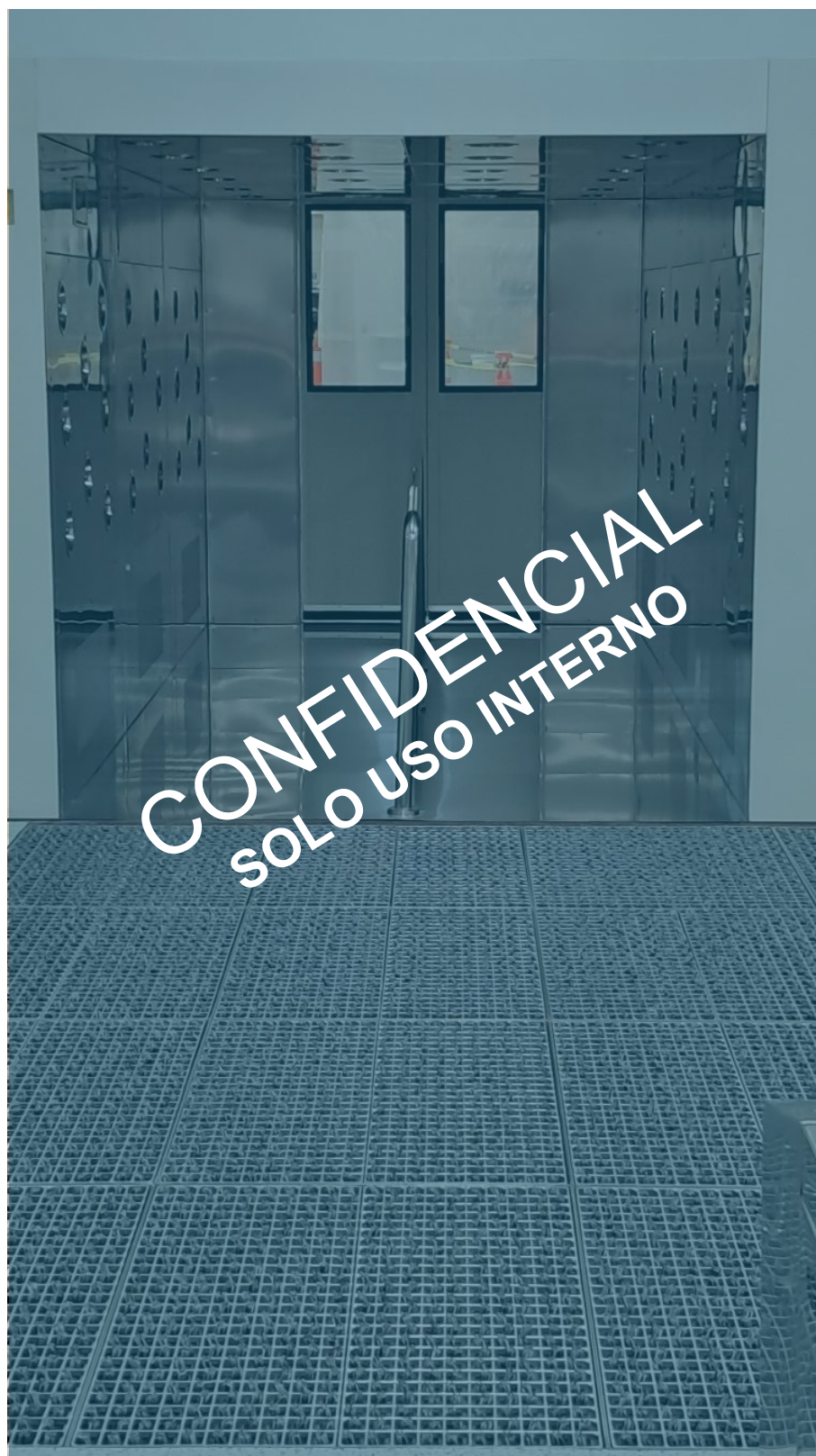
8. Sistema antipolvo para calzado llamado Profilgate, dos Air Showers personalizados con capacidad conjunta de hasta 160 personas por minuto.
